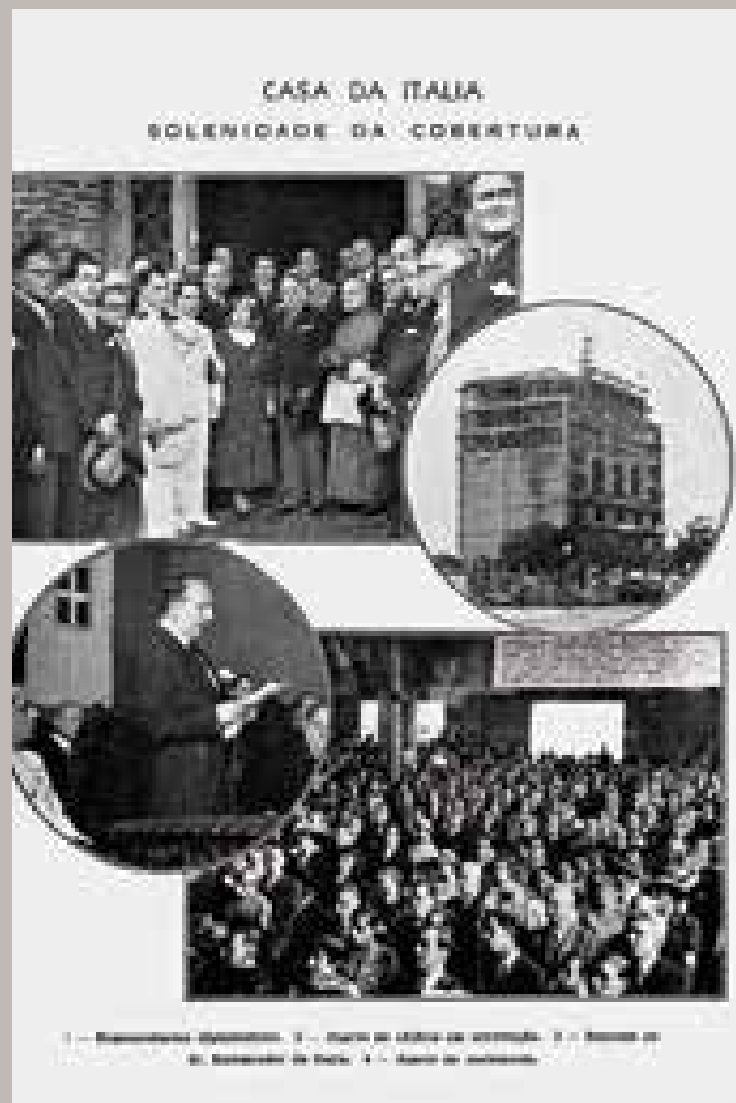
A festa da cumeeira da Casa d'Italia atraiu um grande público ao auditório, ainda inconcluso e sem janelas. O evento é tradicionalmente promovido quando uma edificação alcança a cobertura de seu último andar [Revista Careta, 4/4/1936, p. 32. Fonte: Hemeroteca Digital da Biblioteca Nacional]
